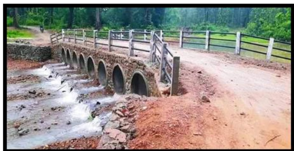
वडा नं. ७, माटेखाँडी खोलामा निर्मित ट्युमपाईप कल्भर्ट ।
