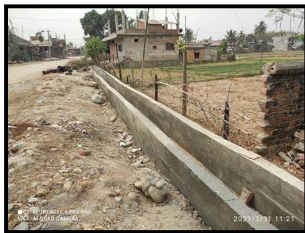
वडा नं. ५ सिवाई चौक देखि उत्तर त्रियुगा नदी सम्म ढल निर्माण ।
