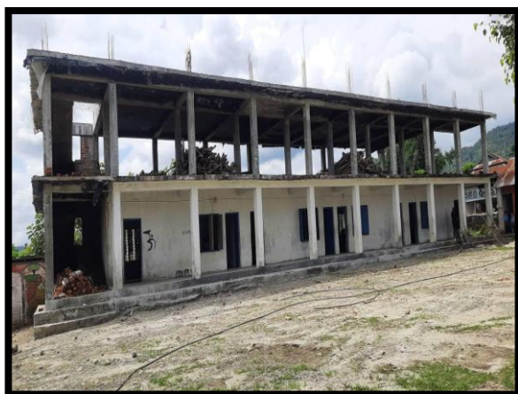
वडा नं. २ माडीबासमा सञ्चालित सिंहदेवी मा.वि.को निर्माणधिन भवन ।
