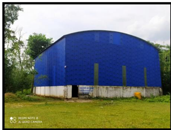
वडा नं. ६, समावेशी खेल मैदानमा निर्मित कवर्डहल निर्माण ।
