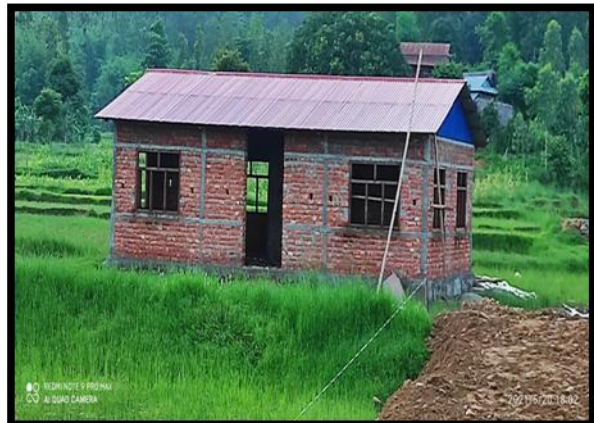
वडा नं. १०, खैराभोरामा निर्माणाधिन आधारभूत स्वास्थ्य केन्द्र भवन ।
